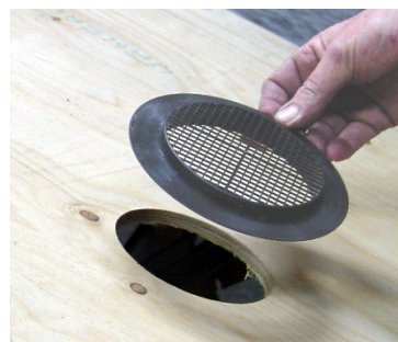
Flangen påføres fugemasse og UV 2003 monteres.
