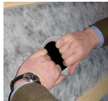
Et Ø 100 mm hul tildannes og tætningsringen monteres.
